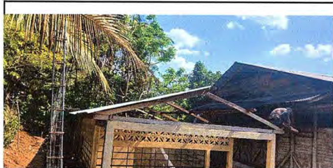
Foto 1: Sustituyendo el techo de la cocina
