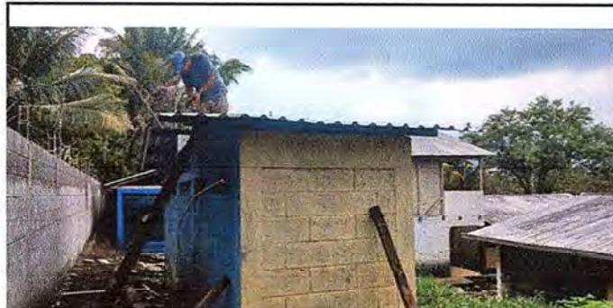
Foto 3: Colocacion de techo para los baños del Centro Educativo
