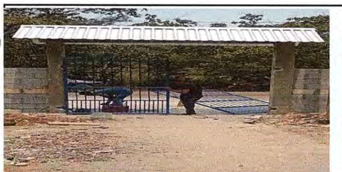
Foto 5: Colocando la sustitucion del porton y el techo.
