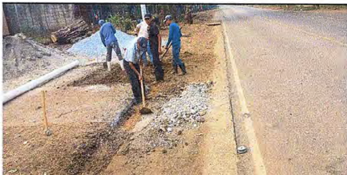
Foto 4: Colocando los tubos y luego la torta de concreto para drenar el agua en la entrada al Establecimiento Educativo
